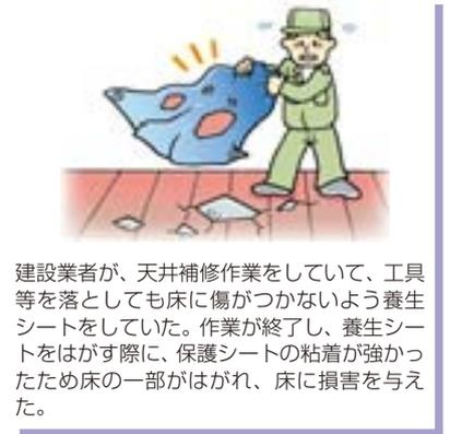
建設業者が、天井補修作業をしていて、工具等を落としても床に傷がつかないように養生シートをしていた。作業が終了し、養生シートをはがす際に、保護シートの粘着が強かったため床の一部がはがれ、床に損害を与えた。
